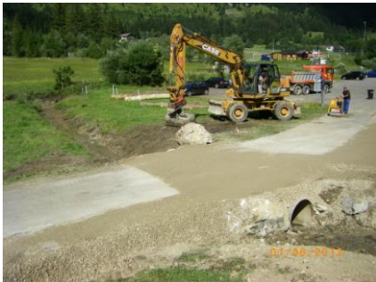
Rohrdurchlass beim Agrarstadel
